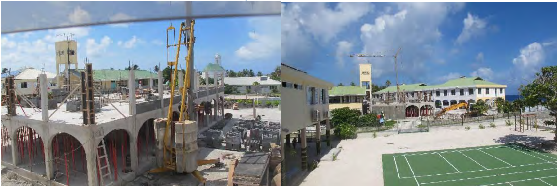
Chantier de l'abri qui hébergera les salles de classes
